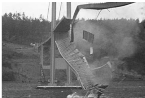
Havárie zavěšeného mostu v Tacomě, W, USA (1941) vlivem ztráty aeroelastické stability typu torzní flutter – délka havarovaného pole: 853,4 m.
