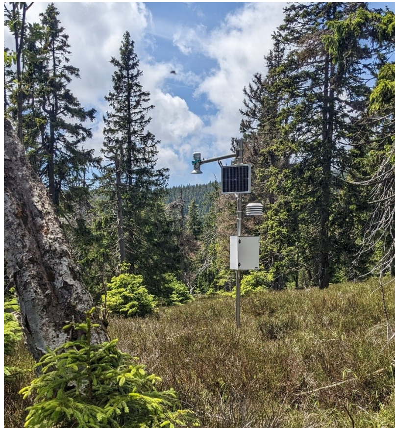
Sněhoměrná stanice ČHMÚ Pod Jelení Studánkou (instalace v červnu 2024
