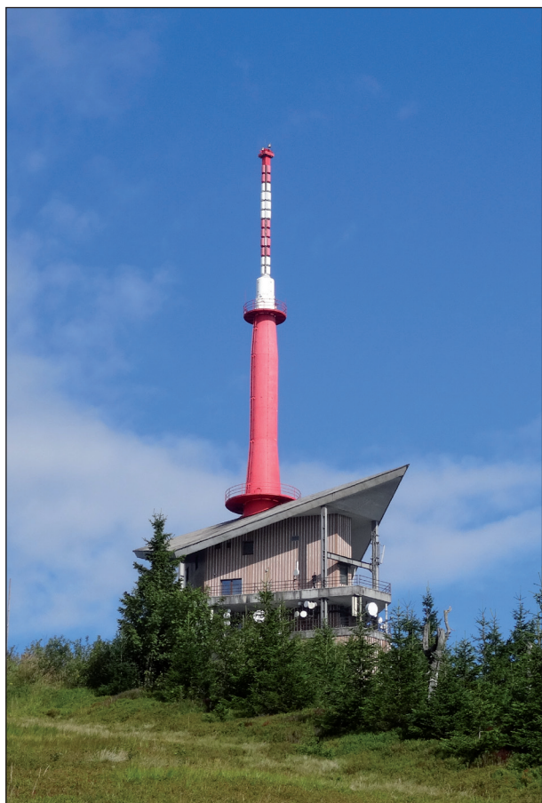
Obr. 39 Největší dominanta Lysé hory, vysílač Českých radiokomunikací, foto Radim Tolasz.
