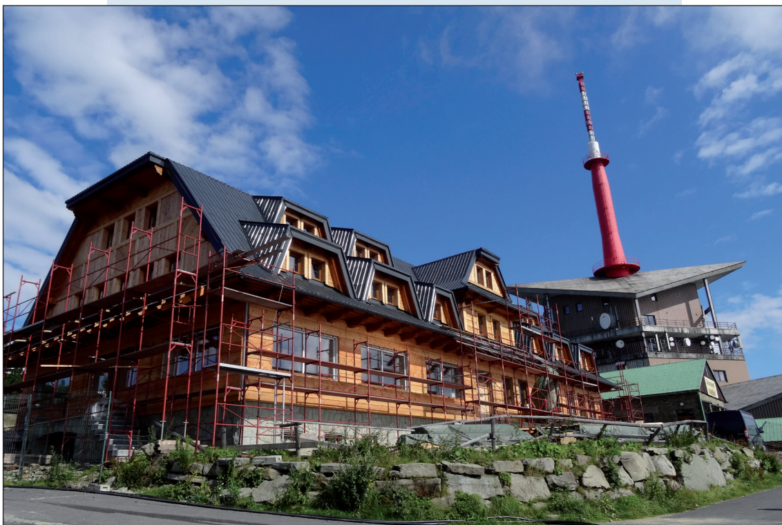
Obr. 37 Výstavba nové chaty Maratón, foto Radim Tolasz.
