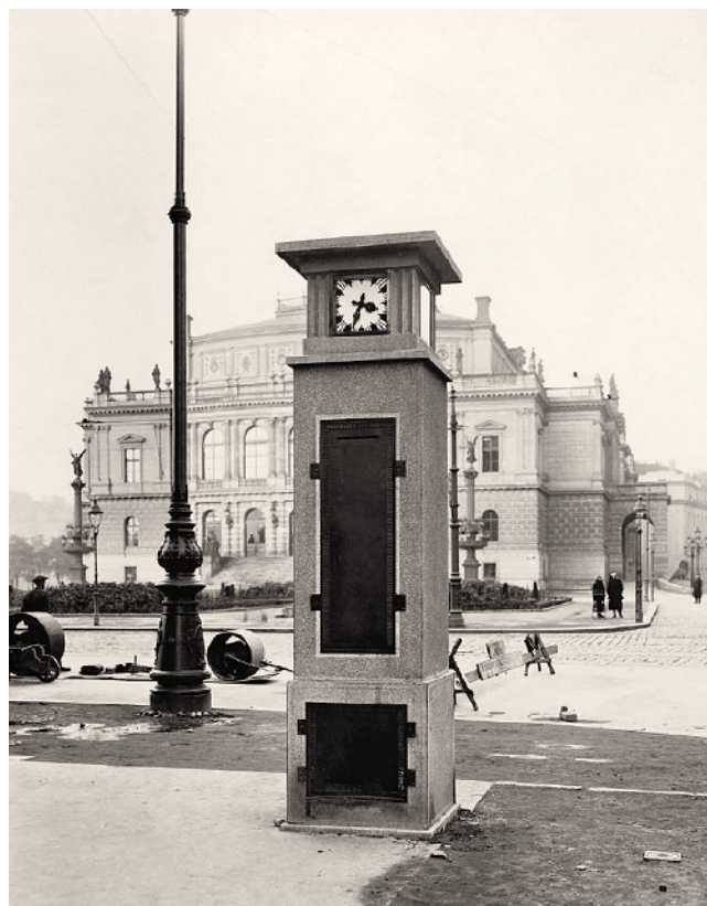
Hodinový sloup, respektive automat veřejného osvětlení s hodinami elektrické rozvodné sítě před Rudolfinem v roce 1928. Převzato z knihy: Jan Doležálek – Drahomír Ruta, 120 let jsme energie tohoto města, Praha 2016.
