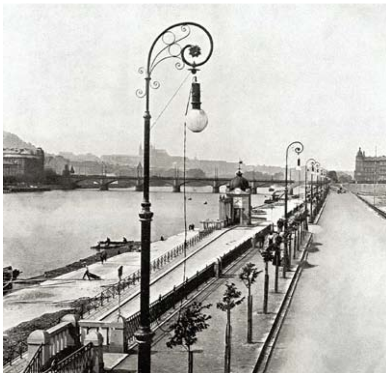
Umístění novostavby vodoměrného a meteorologického domku na Vyšehradském nábreží v roce 1909. Foto: A. Bayer pro časopis Český svět V, č. 42–43, 1909, 30. 7., s. 346. Dostupné z: https://ndk.cz/ .
