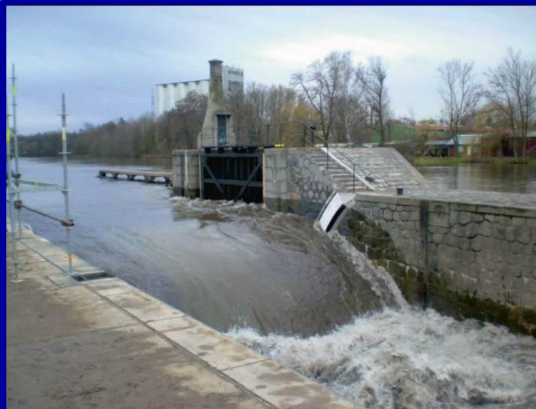
převádění povodňového průtoku plavebním kanálem a PLK
