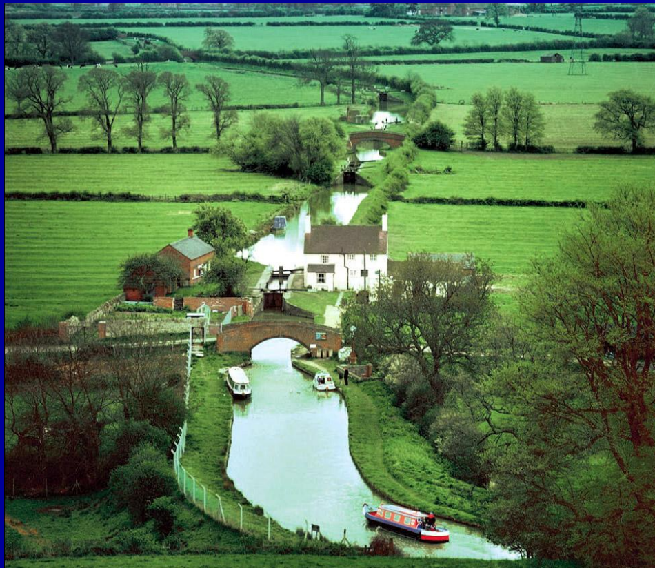
Stará anglická vodní cesta s úzkým korytem a velmi četnými nízkými plaveními stupni
