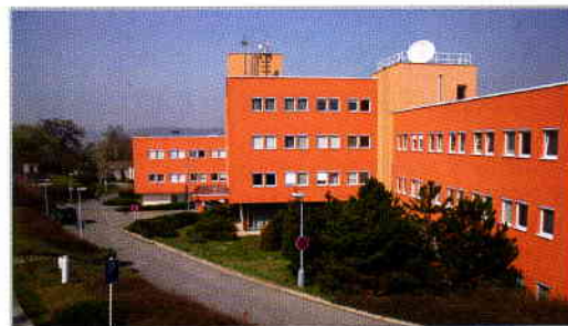
Současné sídlo ČHMÚ a pobočky Praha v Praze-Komořanech. The present CHMI headquarters and the Prague Regional Office in Prague-Komořany.
