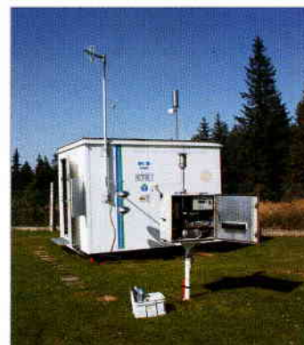
Stanice automatického imisního monitoringu (AIM) na Churáňově. Automated ambient air pollution monitoring station (AIM) on Churáňově.
