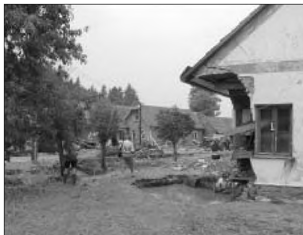
Obr. 1 Následky průchodu povodňové vlny obcí Crhov. Foto J.Svoboda.
